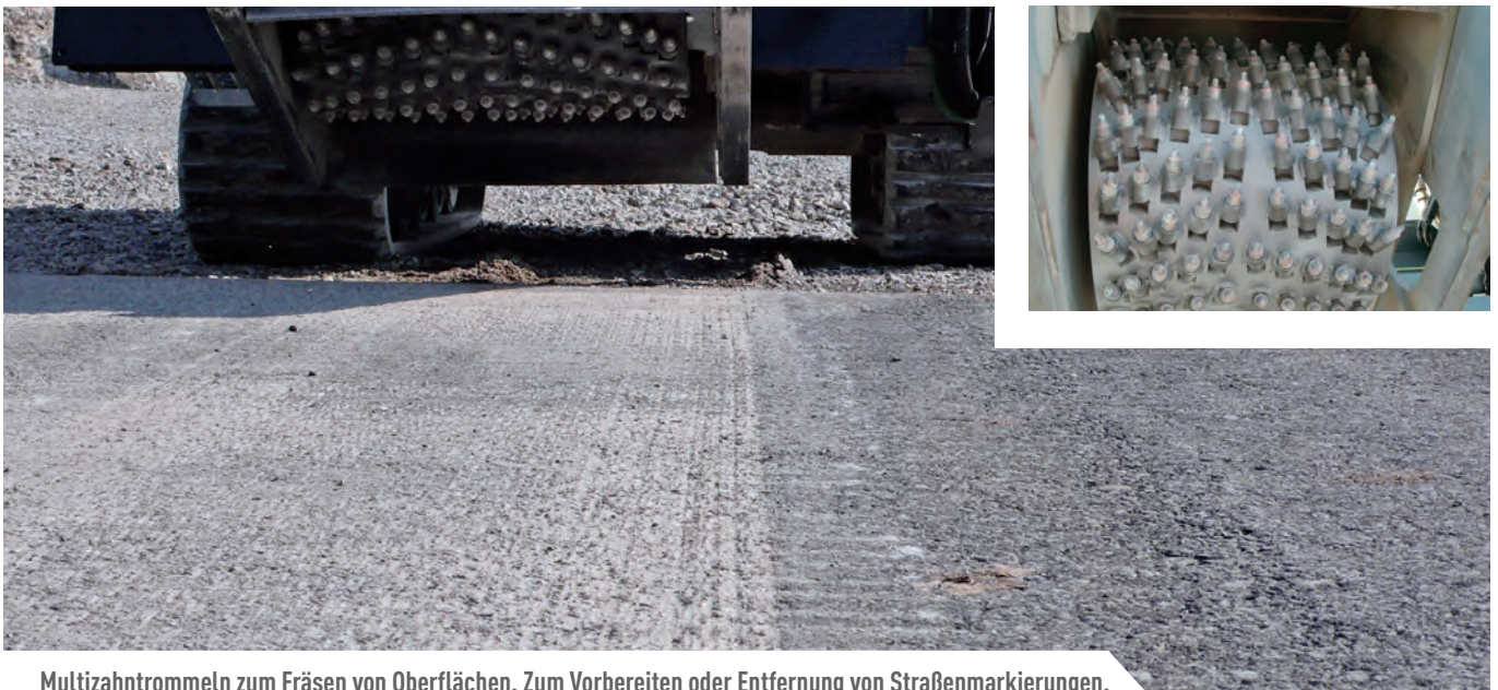
Multizahntrommeln zum Fräsen von Oberflächen. Zum Vorbereiten oder Entfernung von Straßenmarkierungen.
