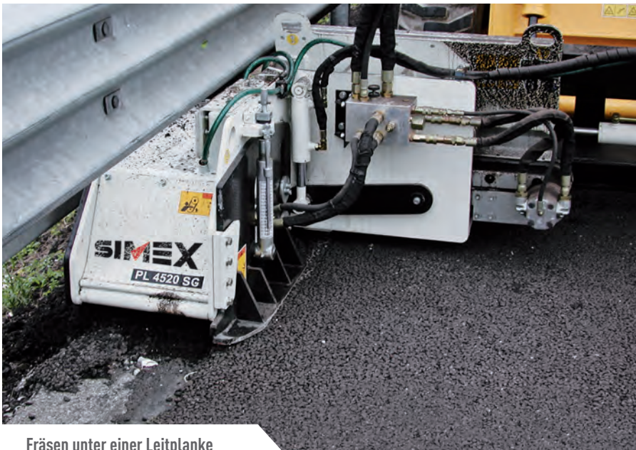
Fräsen unter einer Leitplanke
