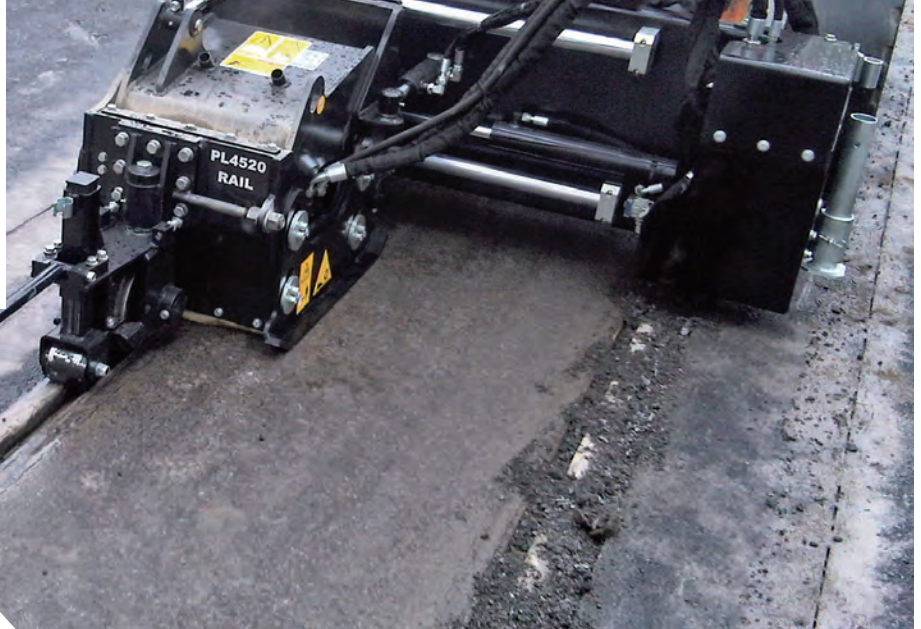
Fräsarbeiten entlang von Straßenbahnschienen
