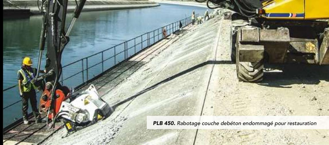
**PLB 450. Rabotage couche de béton endommagé pour restauration**
